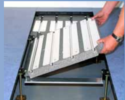
3. Einlegen der Wärmedämmkassetten mit Wärmeleitblech.
