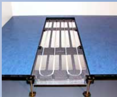
5. Fertig installierte Wärmedämmkassetten.
