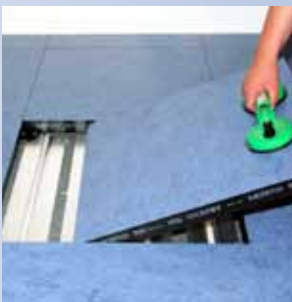
1. Aufnehmen mit Hebwerkzeug, einseitig angesetzt.
