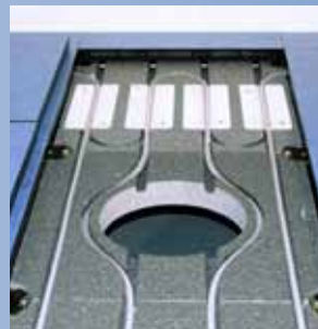
3. Steckdosenplatten können nachträglich in ihrer Lage verändert werden. Es ist dann lediglich das Wärmeleitblech herauszunehmen und die Isolierung entsprechend der Steckdosengröße auszuscheiden oder umzulegen.
