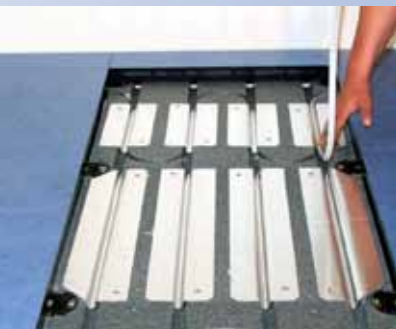
4. Verlegen der Medienleitungen.
