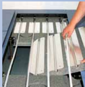
2. Heizleitungen ausclippen. Wärmedämmkassette einfach mit der Hand schräg nach oben herausnehmen. Elektrokabel sind jetzt zugänglich.
