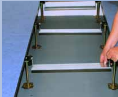
2. Einhängen der Trägerprofile für die Auflage der Wärmedämmkassetten.
